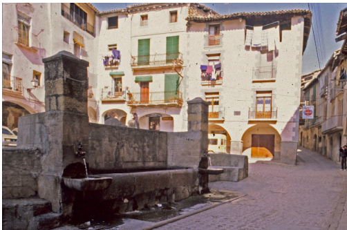
Plaça Talarn – estado inicial
