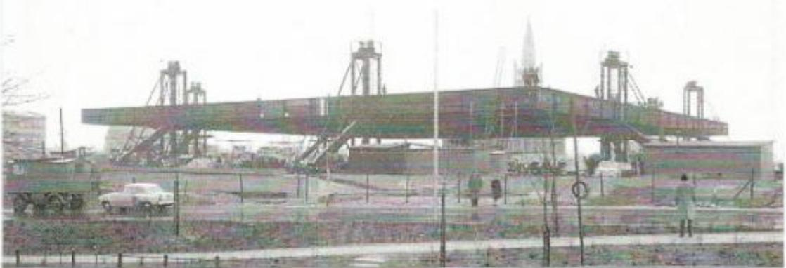
Tal como había pronosticado años antes Mies en repetidas ocasiones, conseguía levantar hidraulicamente superficies que, construidas mediante bóvedas de hormigón ( Edificio de oficinas Bacardí en Santiago de Cuba ) sería inviable.
