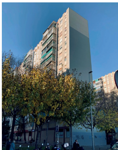
Figura 13: Se ha procedido a aislar los testeros por el exterior. Robert Terradas (2020)
